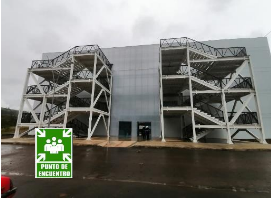
Punto de encuentro 1: Edificio Aulas
